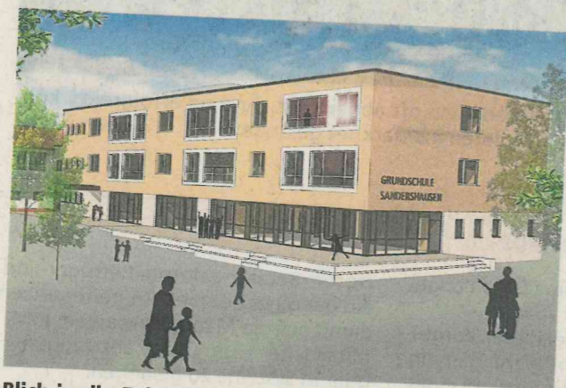
Blick in die Zukunft: In dem geplanten Neubau sollen Klassenzimmer, Differenzierungsräume und eine Mensa entstehen.
